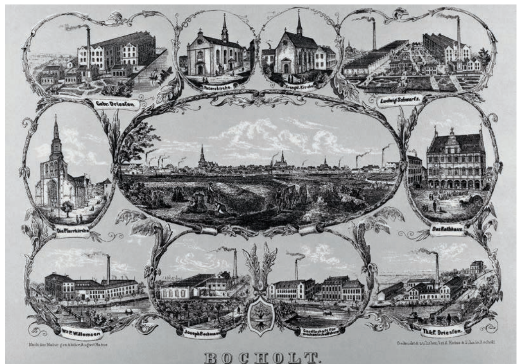
Fabrik- und Kirchengebäude in Bocholt, 1864
